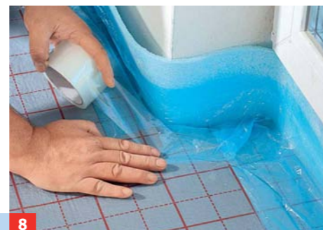
8 Die Folienschürze ziehen Sie dann bis auf die Dämmplatte und verkleben sie mit Klebeband. Die Fläche muss bis ...
