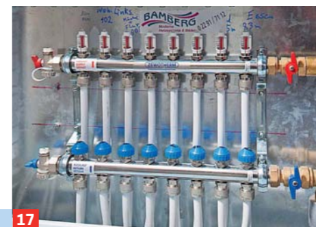
17 Die Dichtheitsprüfung einem Fachmann überlassen 2) , je nach Hersteller ist ein Befüllen mit doppeltem Betriebsdruck nötig.
