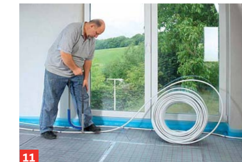
11 Das Verbundrohr mittels Tackermontagegerät, das Sie beim Anbieter ausleihen können, auf den Dämmplatten fixieren.
