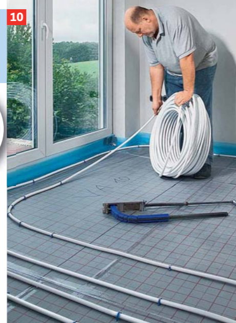
12 Setzen Sie die Tackerklammern mindestens alle 50 cm, vor und nach einem Bogen zwei Klammern enger setzen.
