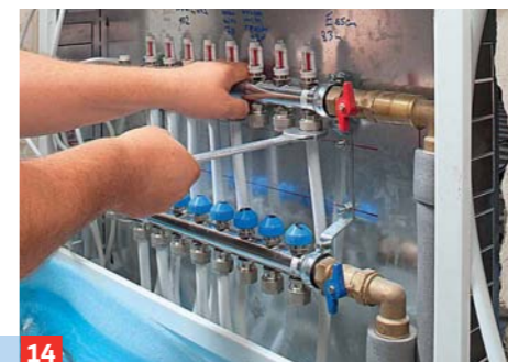
14 ... Verteiler mittels Klemmverschraubung befestigt: Überwurfmutter über das Rohrende schieben, dieses bis zum Anschlag ...
