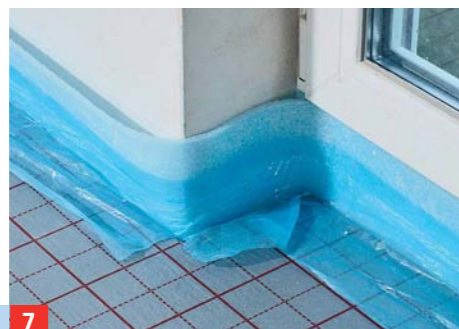
7 ... ausgeführt sein. Die Platten(abschnitte) bis an den Randdämmstreifen unter dessen seitliche Folienschürze schieben.
