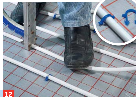
12 Setzen Sie die Tackerklammern mindestens alle 50 cm, vor und nach einem Bogen zwei Klammern enger setzen.
