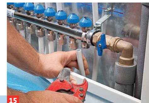
15 ... in den Anschlussstutzen einführen und die Mutter festziehen. Zum Ablängen eine Schere für Kunststoff- und Metallrohre ...
