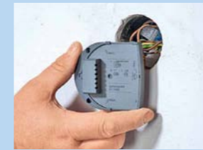
Elektronische Thermostate in jedem Raum anschließen. Sie benötigen 230 Volt.
