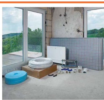
5 Die Dämmplatten werden auf Stoß verlegt. Vor allem bei folgendem Fließestrich verklebt man sie mit PE-Klebeband.
