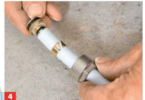
4 Anschluss per Klemmringverschraubung: Überwurfmutter übers Rohr stülpen, Klemmring aufstecken, Stützkörper bis zum Anschlag ...
