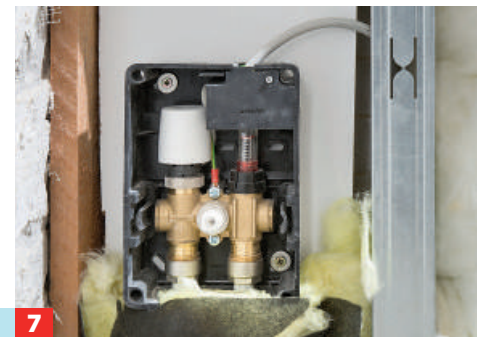
7 Bevor man das Vorwand-system verkleidet, kann man die Hohlräume gegen Fließgeräusche (z. B. von der Spülung) dämmen.
