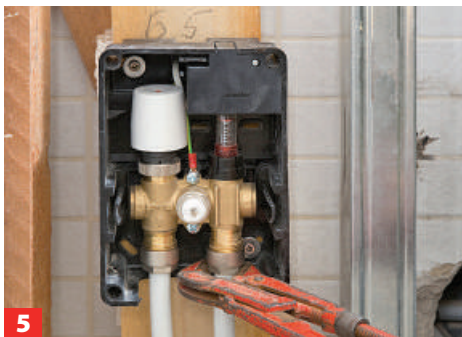
5 ... ins Rohr einschieben. Das Rohr ins Formstück am Verteiler einführen, die Mutter erst per Hand, dann mit Schlüssel oder Zange ...
