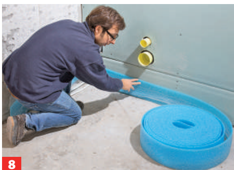
8 Damit der Estrich später schalldämmt von den Wänden entkoppelt ist, verlegt man umlaufend einen Randdämmstreifen.
