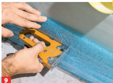
9 Die Folienschürze muss nach innen zum Raum hin zeigen. Den Dämmstreifen festtackern oder mit doppelseitigem Klebeband befestigen.
