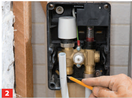
2 Das Aluverbundrohr kann für den Anschluss am Verteiler problemlos abgelängt werden.
