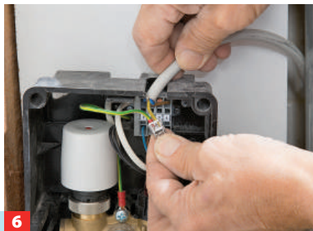
6 ... festziehen. Hat man thermische Stellantriebe für die Heizungssteuerung, muss man noch für einen Stromanschluss sorgen.
