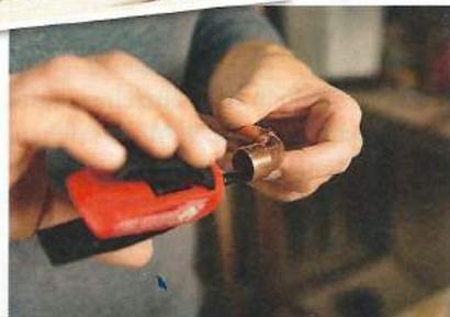
**VERBUNDEN** werden die Rohre und Fittings mit Klebstoff oder mit Lötzinn.
