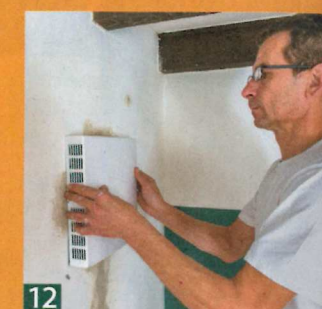
08 Die Abdeckung wird mit vier Schrauben an Wand und Mantelrohr befestigt. Die Kabel werden in die Elektronikbox eingeführt.
