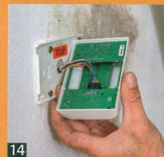
10 Die Anschlüsse des Geräts nach Anleitung mit Lüsterklemmen verbinden. Dann die Boxen mit den Abdeckungen schließen.
