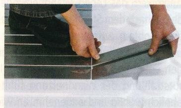
**2** Wärmeleitbleche werden daraufhin mit fünf Millimeter Abstand passend verlegt. Sollbruchstellen garantieren eine optimale Anpassung.
