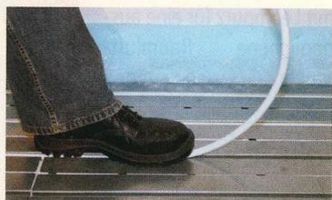
**3** Abschließend können Sie in die fertig verlegten Wärmeleitbleche das Heizrohr einfach mit dem Fuß fixieren.
