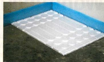
**1** Die Profilplatte „Rondo Plus“ wird, in einer Raumecke beginnend, fugendicht unter die Folienstürze des Randdämmstreifens verlegt. Anschließend legt man Folgeplatten mit Stufen-Hakenfalz an und verbindet sie miteinander.
