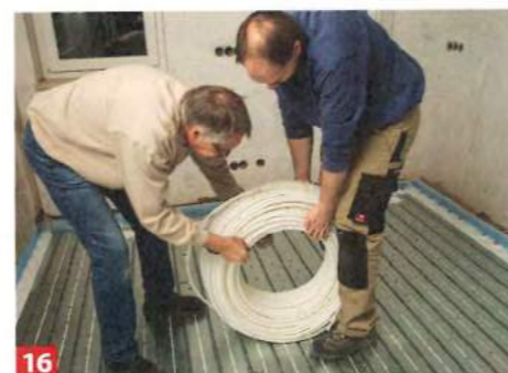
16 Ein Ende am Vor- oder Rücklauf befestigen. Dazu Rohr ablängen, Überwurfmutter und Klemmring überstülpen, Stützkörper ins ...
