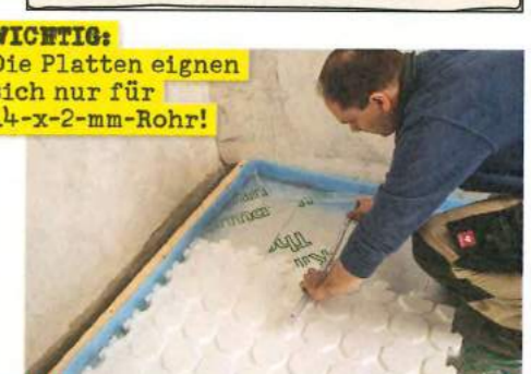
9 Legen Sie die Platten bündig an den Randdämmstreifen und lassen dessen Folie überlappen. Restabstand in Reihe 1 ausmessen.
