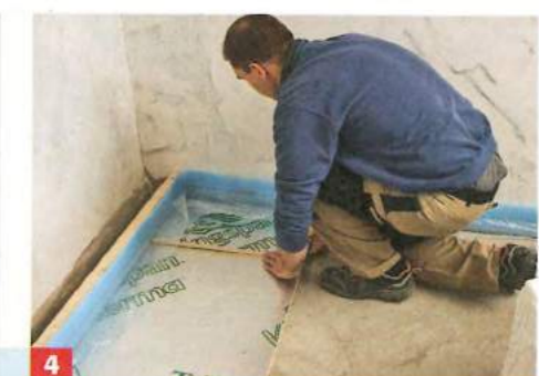
4 ... exakt und leicht zuschneiden, sodass Endstücke passgenau eingesetzt werden können.
