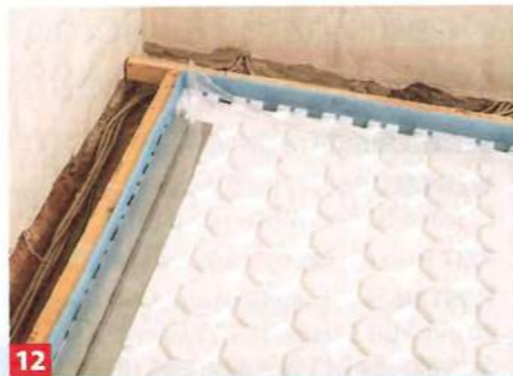
12 Sind die Systemplatten verlegt, setzt man jetzt die Wärmeleitbleche ein. Auch hier die Folie des Dämmstreifens überlappen lassen.
