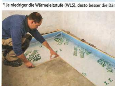
5 Beginnen Sie mit dem Reststück von vorne die nächste Reihe, so haben Sie automatisch etwas Versatz, der die Fläche stabilisiert.
