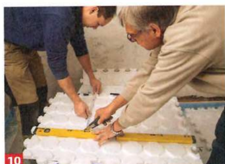
10 Der Zuschnitt erfolgt erneut problemlos mit Cutter. Halten Sie aber ein Schneidelineal, eine Latte oder eine Wasserwaage bereit.
