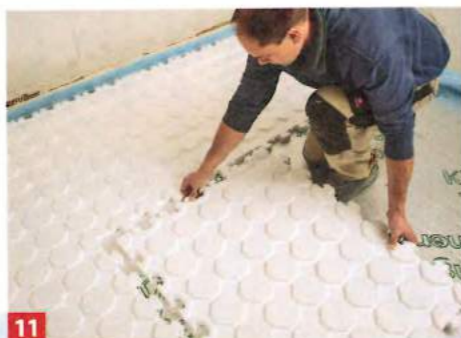
11 Die 1035 x 785 x 25 mm großen Platten verfügen über einen Stufenhakenfalz, mit dem sie bündig zusammengesetzt werden können.
