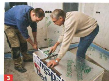
3 ... Stärke an, hier sehr gut dämmender PUR der WLS 024 1) . Diese aluminiumkaschierten Hartschaumplatten lassen sich mit Cutter ...
