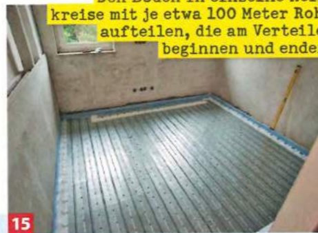
15 ... um einen guten, gleichmäßigen Wärmeübergang zu erzielen (bei Trockenestrich zwingend erforderlich). Es folgt das Heizrohr.
