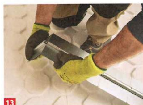
13 Alle 100 mm verfügen die Wärmeleitbleche über Sollbruchstellen, sodass man sie werklos ablängen kann. Das Reststück ...
