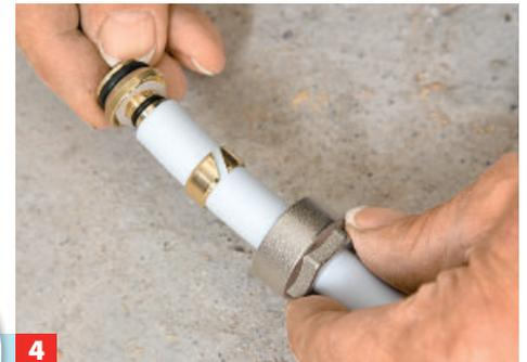
Anschluss per Klemmringverschraubung: Überwurfmutter übers Rohr stülpen, Klemmring aufstecken, Stützkörper bis zum Anschlag ...
