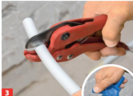
Mit Rohrschere schneiden, die Rohrenden mit Kalibrierwerkzeug entgraten.
