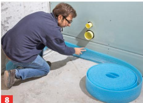
Damit der Estrich später schallgedämmt von den Wänden entkoppelt ist, verlegt man umlaufend einen Randdämmstreifen.
