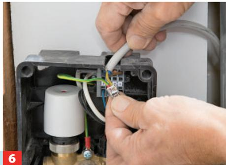
... festziehen. Hat man thermische Stellantriebe für die Heizungssteuerung, muss man noch für einen Stromanschluss sorgen.
