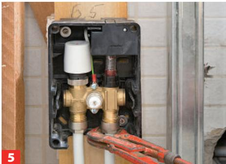
... ins Rohr einschieben. Das Rohr ins Formstück am Verteiler einführen, die Mutter erst per Hand, dann mit Schlüssel oder Zange ...
