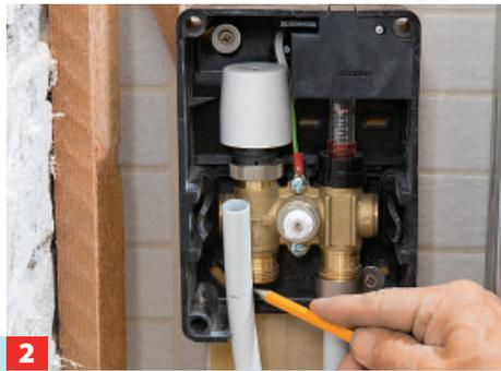
Das Aluverbundrohr kann für den Anschluss am Verteiler problemlos abgelängt werden.
