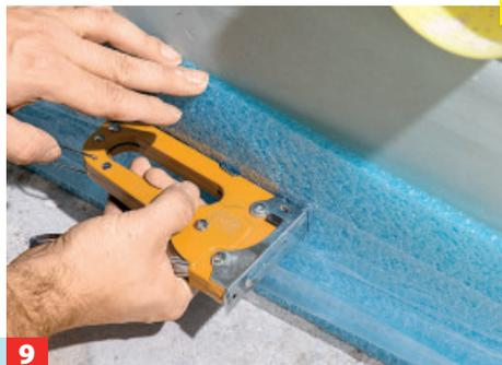
Die Folienschürze muss nach innen zum Raum hin zeigen. Den Dämmstreifen festtackern oder mit doppelseitigem Klebeband befestigen.
