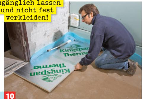
Um den Boden gegen Kellerkälte zu dämmen, verlegte der Bauherr Polyurethanplatten in 20 mm Stärke.
