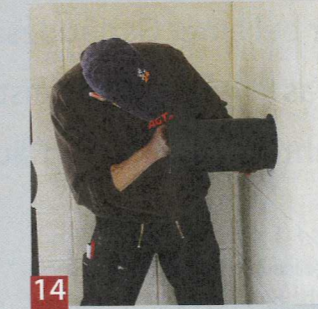
10 ... der im Abgassystem erhaltenen Klemmbändern miteinander verbunden. Je nach Schornsteinhöhe folgt ...
