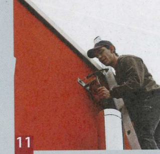
07 Das erste Längenelement wird provisorisch auf den Schornstein gesteckt und so die Lage der Wandhalterung ermittelt.
