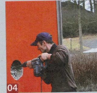
02 ... Aufnahme des Zentrierbohres des Kernbohrers erstellt und dann die Hauptbohrung angefertigt.
