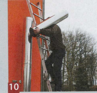
06 ... mit Hilfe einer Wasserwaage senkrecht und waagrecht ausgerichtet, dann die Wandhalterung bzw. -konsole angeschraubt.
