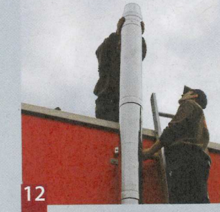
08 Die Edelstahlschelle wird mit der Wandhalterung verbunden, dann das Rohr wieder aufgesteckt und mit der Schelle montiert.
