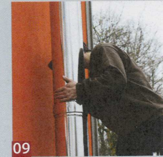
05 Die Wandhalterung, das Reinigungselement und der Feuerungsanschluss werden zusammengesteckt, positioniert und ...
