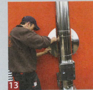
09 Nach und nach werden die Längenelemente aufeinander gesteckt. Die einzelnen Bauteile werden dabei mit Hilfe ...
