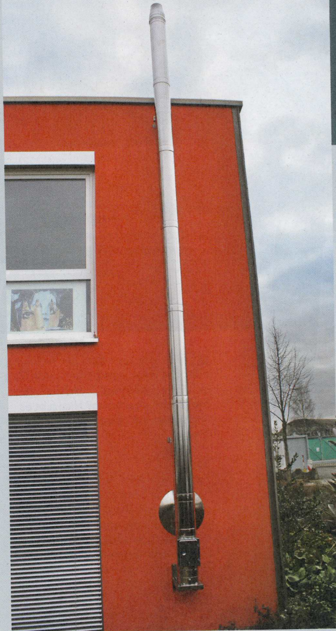
01 Die Lage des Mittelpunktes der Rohrdurchführung durch die Wand nach außen wird ermittelt. Dann wird das Loch für die ...
