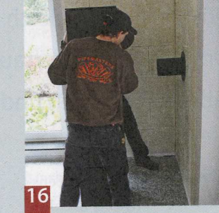
12 ... wird der Mündungsabschluss montiert. Dann wird der Schornstein ausgerichtet und mit der Wandhalterung verbunden.
