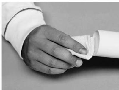
Tragen Sie den Kleber auf das Rohr auf, schieben Sie das Rohr in die Muffe oder den Bogen und warten Sie dann ca. 1 Minute. Jetzt haben Sie eine unlösbare Verbindung zwischen Rohr und Muffe bzw. Bogen geschaffen.
