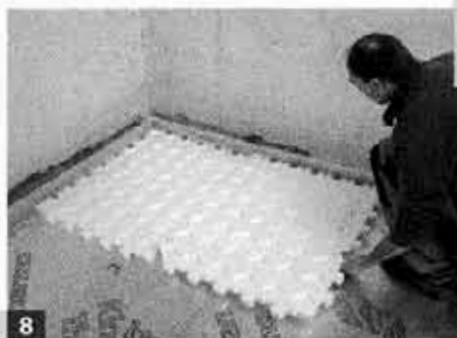
8 Auf die Dämmschicht folgen nun die EPS-Systemplatten für Trockenestrich, in die das Heizrohr gesteckt werden kann.
