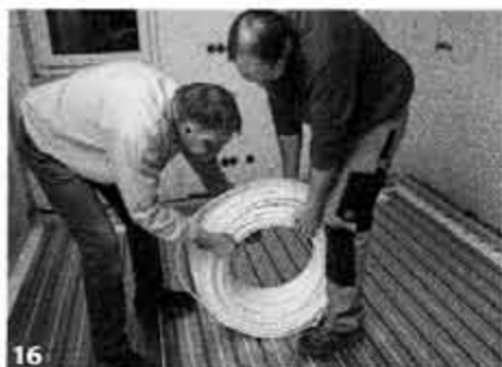
15 Den Boden in einzelne Heizkreise mit je etwa 100 Meter Rohr aufteilen, die am Verteiler beginnen und enden. ... um einen guten, gleichmäßigen Wärmeübergang zu erzielen (bei Trockenestrich zwingend erforderlich). Es folgt das Heizrohr.
