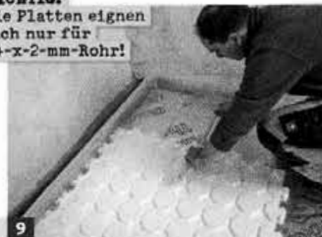
9 Legen Sie die Platten bündig an den Randdämmstreifen und lassen dessen Folie überlappen. Restabstand in Reihe 1 ausmessen.
