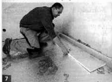
7 Um die Dämmung zu verbessern, legt man eine zweite Lage versetzt darüber (je nach Druckfestigkeit maximal 120 mm gesamt 3) ).
