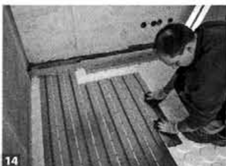
15 Den Boden in einzelne Heizkreise mit je etwa 100 Meter Rohr aufteilen, die am Verteiler beginnen und enden. ... um einen guten, gleichmäßigen Wärmeübergang zu erzielen (bei Trockenestrich zwingend erforderlich). Es folgt das Heizrohr.
