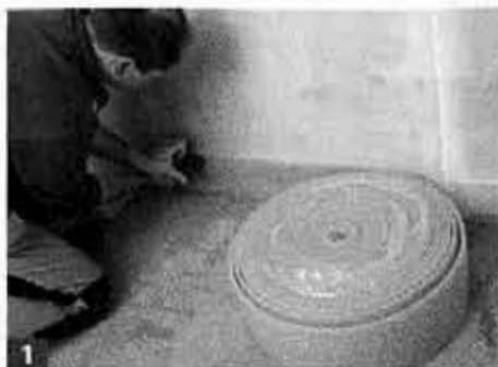
1 Umlaufend an der Wand einen Randdämmstreifen befestigen. Hier wird getackert, es gibt aber auch selbstklebende Streifen.
