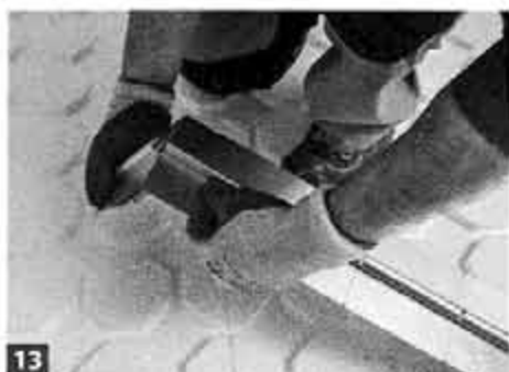
10 Der Zuschnitt erfolgt erneut problemlos mit Cutter. Halten Sie aber ein Schneidelineal, eine Latte oder eine Wasserwaage bereit.
